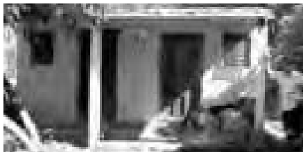
Une des maisons construites
