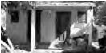
Une des maisons construites
